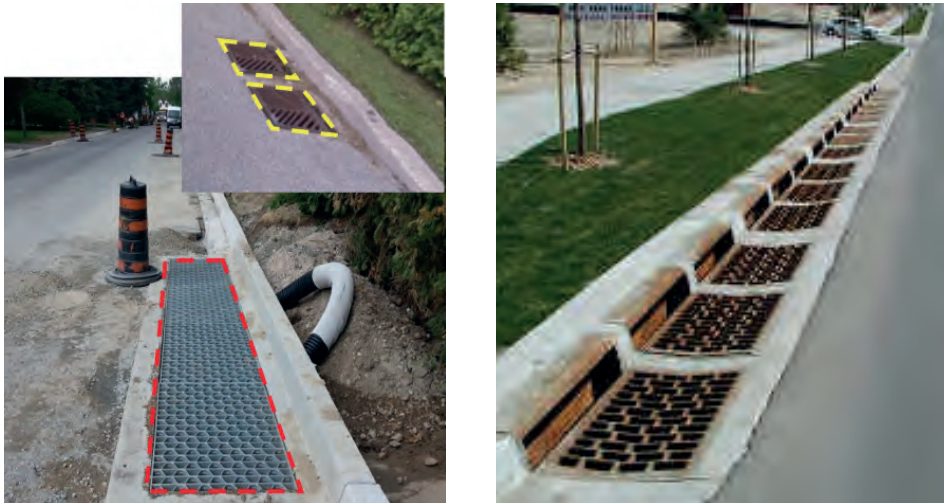
Şekil 8.7. Şiddetli yağışların neden olduğu yüksek miktarlardaki mazgallar artık tahliye edemiyor. Bu nedenle bu örnekte olduğu gibi gelişmiş ülkelerde artık süper ve birleşik mazgallar kullanılıyor.
