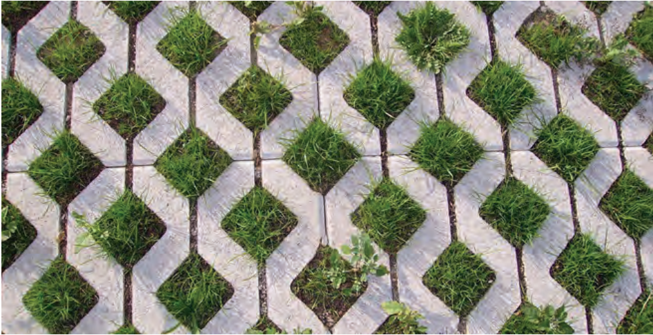
Şekil 8.11. Türkiye’de yaygın bir şekilde kullanılabilecek su geçirimli bir yüzey malzemesine bir örnek.
