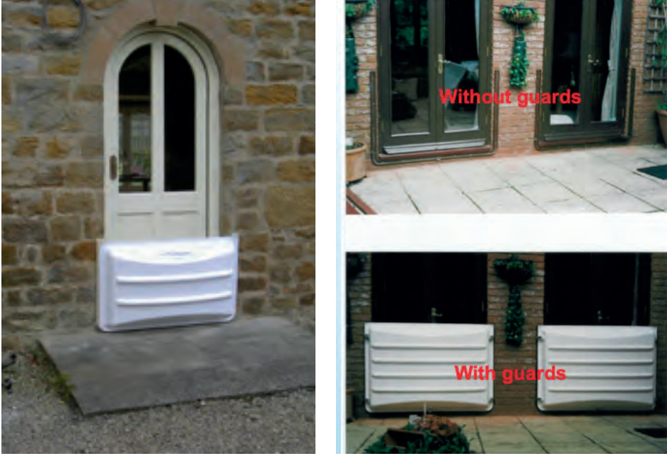
Şekil 8.20. İngiltere’de yaygın olarak uygulaman alçak eşikli kapıları en az 100-yıllık taşkın sularının belirlediği temel su seviyesinin üzerine kadar bir kapakla kapatarak sel sularından koruma önlemine bir örnek.
