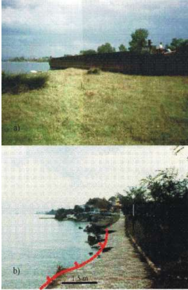
Şek. 2a: Seymen 'de denizin 100 metre açığındaki 40 m. boyundaki duba deprem anında oluşan ve GD 'ye yüklenen dalgalarla karaya savrulmuştur. Bu noktadaki deniz suyu seviyesinin 4 m. kadar yükseldiği saptanmıştır. Şek.2 b: Gölcük 'ün batısında Halidere' de yersel çökme ve su istilası sonucu oluşan kıyılardaki parçalanmalar.
