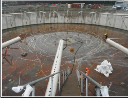
Şekil 5.20. Son Çökeltme Havuzu için Batık Tip Savak Borulaması
