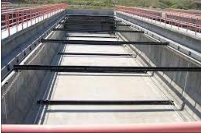
Şekil 5.22. Dikdörtgen Son Çökeltme Havuzu Çamur Toplama Sistemi
