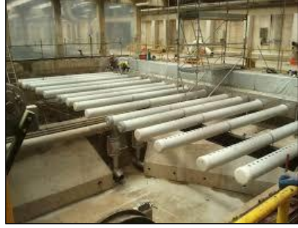
Şekil 5.20. Son Çökeltme Havuzu için Batık Tip Savak Borulaması
