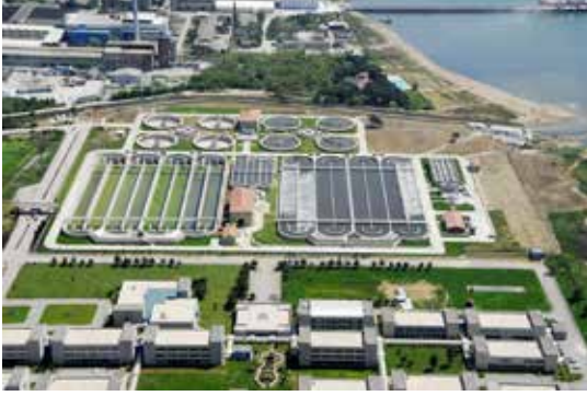
Resim 3 – Gebze Atıksu Arıtma Tesisi
