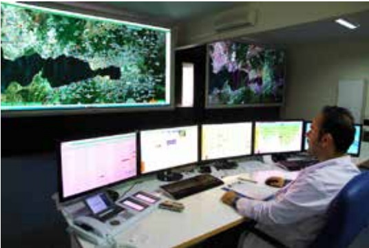
Resim 4: Atıksu SCADA Sistemi
