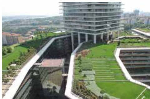
Şekil 9. Zorlu Center, Çatı Bahçe.
