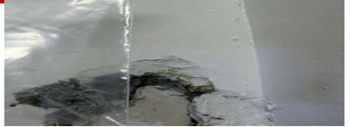
Duvarlar (Spreylenmiş / Yangına Karşı)
