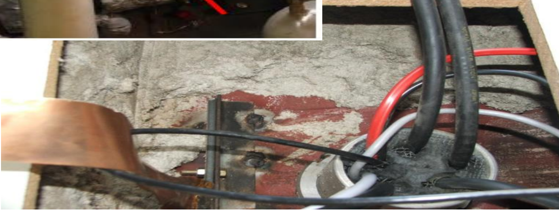
Elektrik Hatları (Spreylenmiş /Termal İzolasyon)
