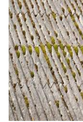
Duvar, Yer ve Çatı Kaplama Malzemeleri
