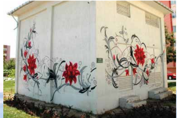
Nilüfer Belediyesi, projeye trafoları daha estetik bir görünüme kavuşturuyor.
