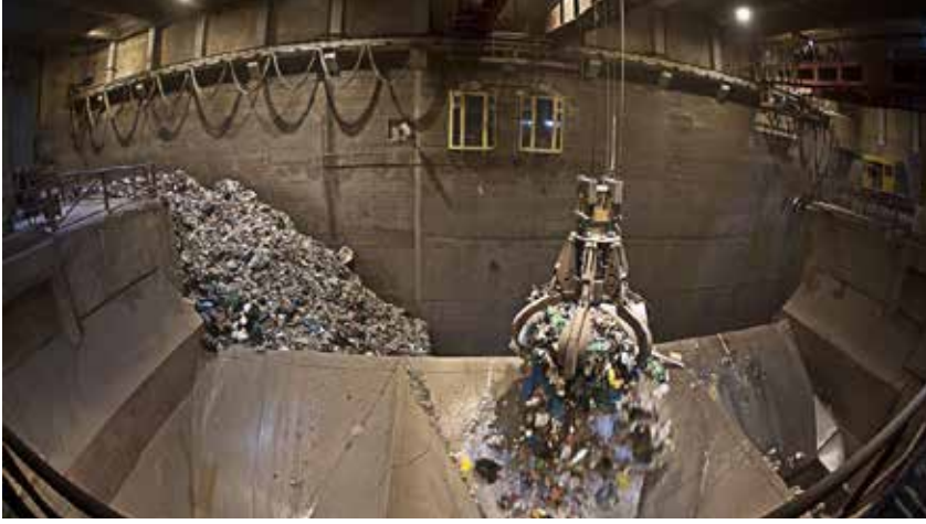
Atıkların karıştırılması ve kazan besleme Mixing the waste and feeding the furnace
